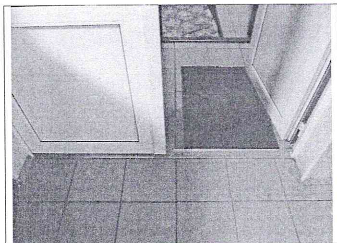
Фото №15 – Внутренняя входная дверь
