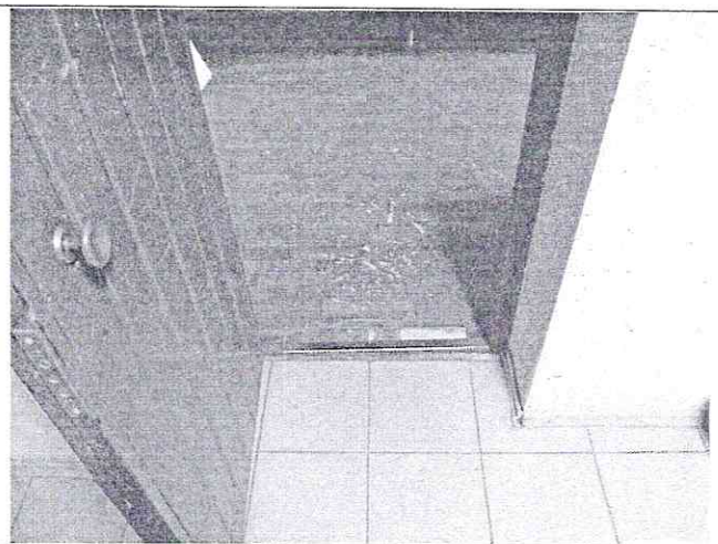
Фото №19 – Пути движения внутри здания (двери)
