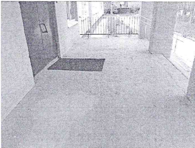
Фото №9 – Входная площадка главного входа
