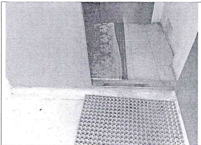
Фото №11 – Наружная входная дверь
