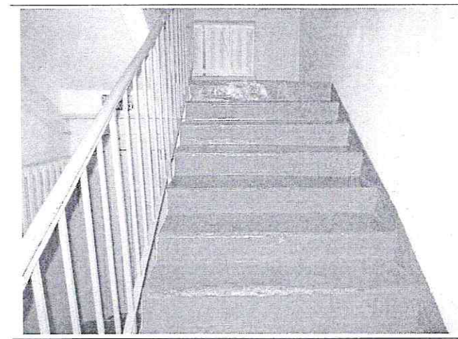
Фото №18 – Пути движения внутри здания (лестницы)
